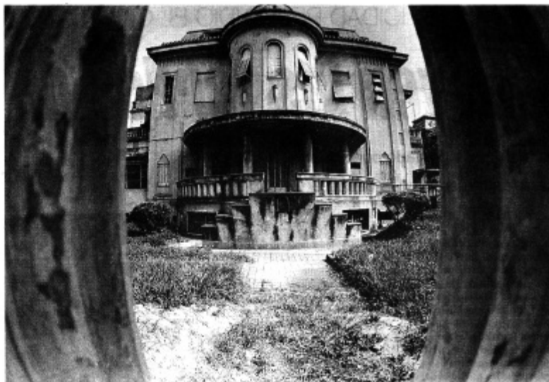
El edificio que ocupa la esquina de Córdoba y Moreno fue sede del Comando del II Cuerpo de Ejército. Los crímenes cometidos contra la población fueron programados en la sede de ese comando.
